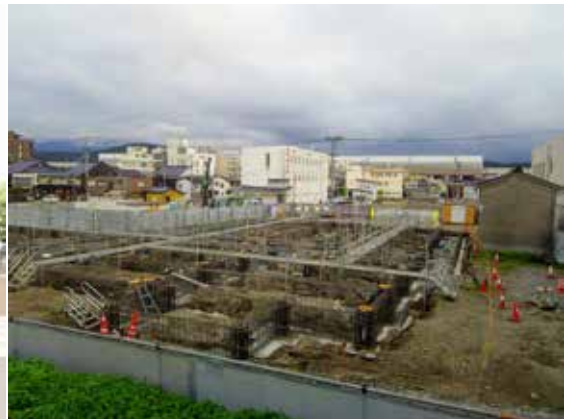
急ピッチで進む基礎工事
