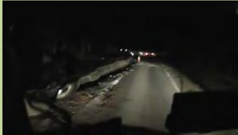
山道は崩れ段差・落石を避けながら進む
