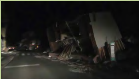
倒壊した益城町を抜けて南阿蘇村へ向かう
